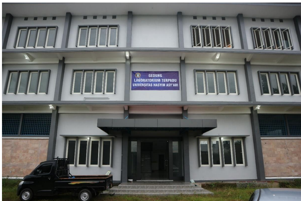
Gambar 4. 17 Gedung Laboratorium Terpadu
