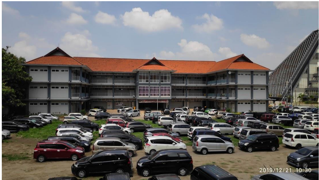
Gambar 4. 14 Gedung Kampus B
