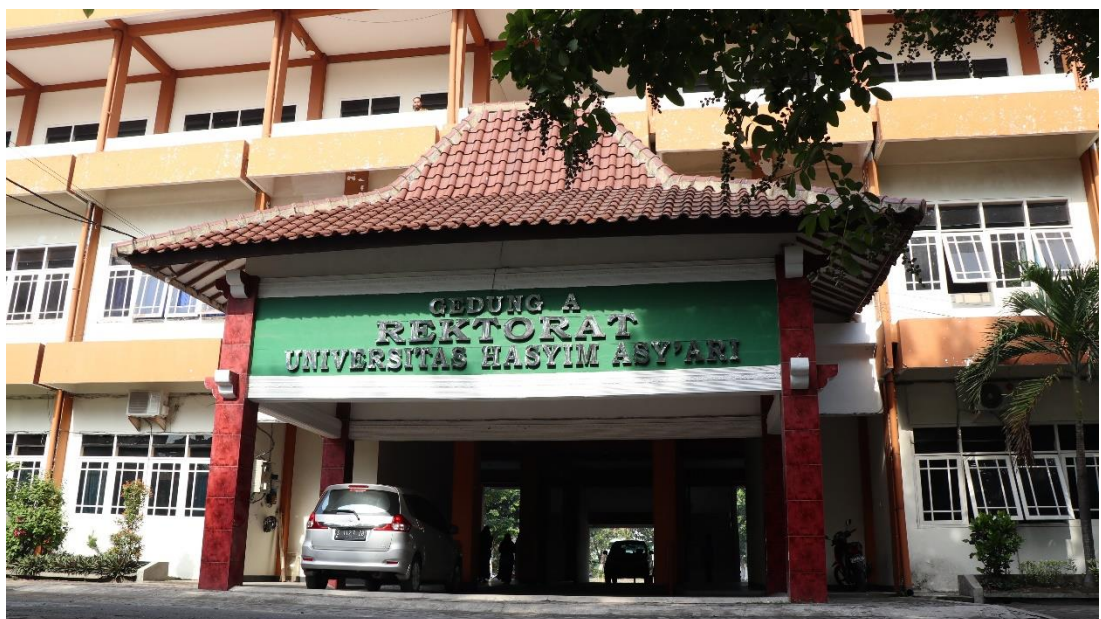
Gambar 4. 13 Gedung Kampus A
